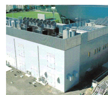
■エネルギー棟
