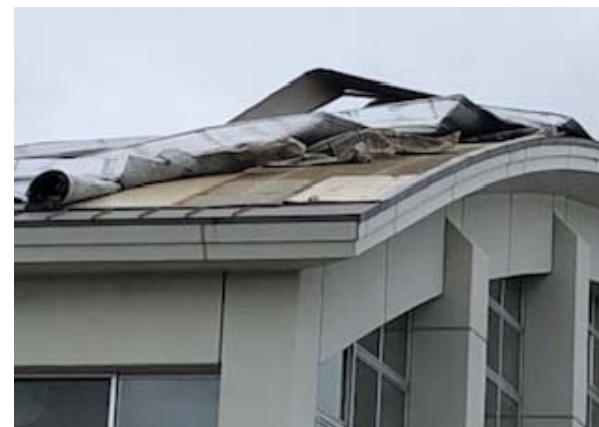
屋根破損状況
